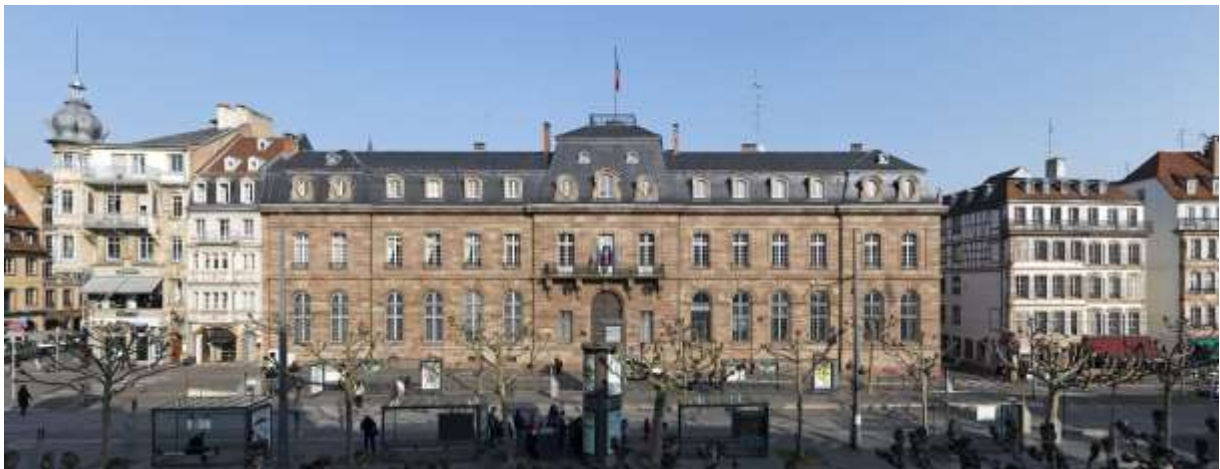
Ill. 43 : Façade principale de la Banque de France, 1926 (façade). Photo Frédéric Harster, 2014.
