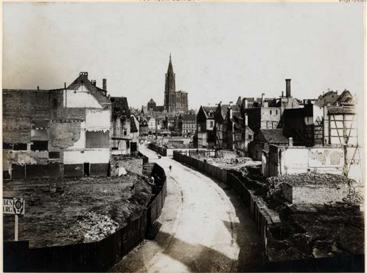
Ill. 34 : Percement de la ville ancienne, début du XX e siècle. Denkmalarchiv © DRAC Alsace (IC0482B227_011-01).
