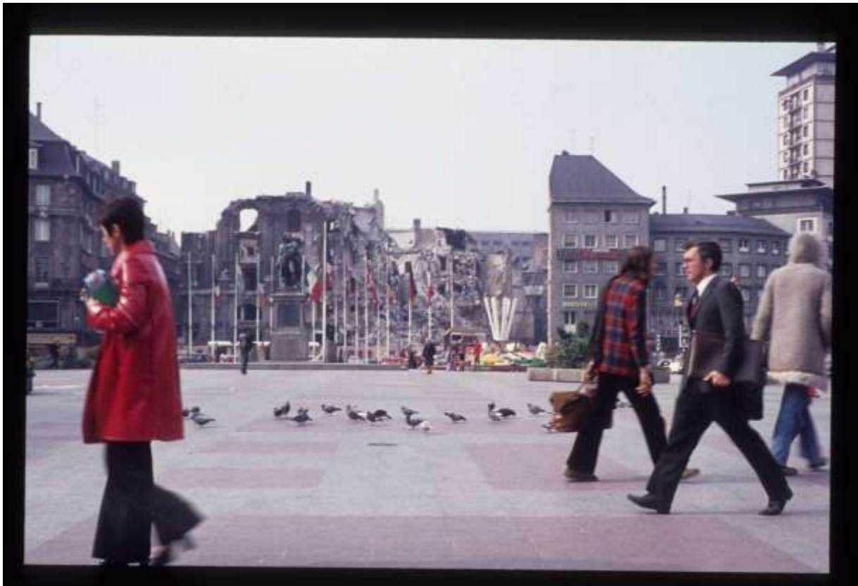
Ill. 66 : Destruction de l'hôtel Maison Rouge, 1973. FORST, Roger. Il était une fois Strasbourg, vestiges disparus après 1870 . Strasbourg : Éditions Coprur, 2010. 320 p.
