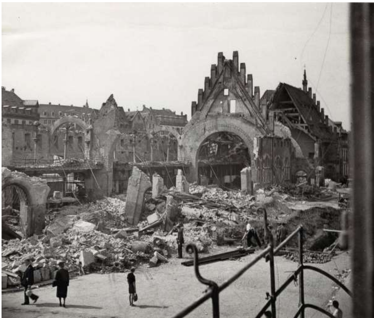
Ill. 53 : L'Ancienne Douane détruite lors des bombardements de 1944. AVCUS (1 FI 102).
