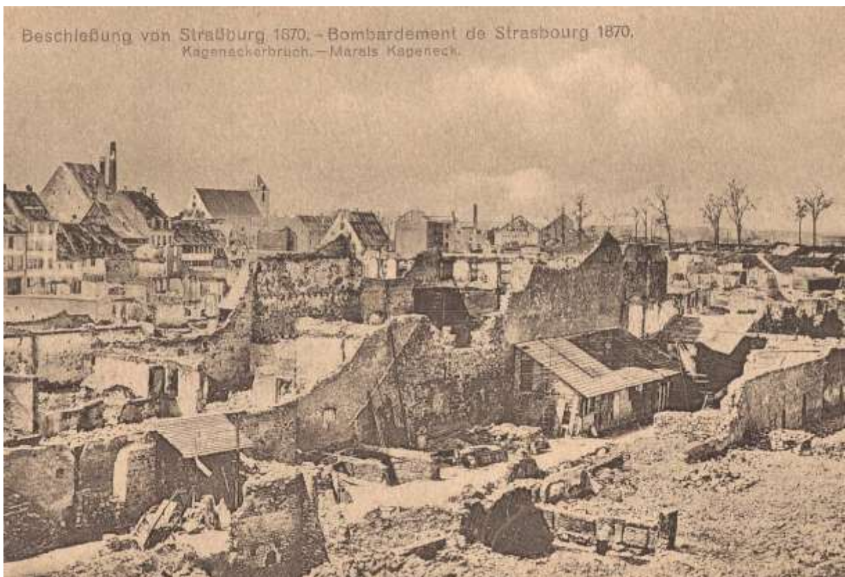
Ill. 9 : Destructiions causées par les bombardements de 1870 dans le quartier Kageneck. AVCUS (1 Fi 230).
