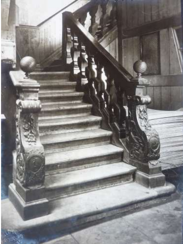
Ill. 47 : Escalier conservé de l'immeuble 20, rue de l'Ail, vers 1930. AVCUS (1 FI 29).
