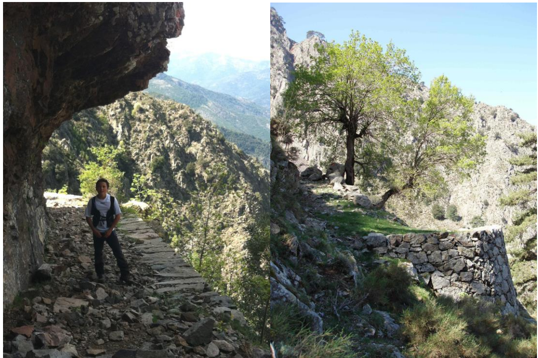
Photo 80. Passage creusé dans la roche (à gauche) et mur de soutènement d'un lacet (à droite) de la route forestière de Caprunale (Manso)
