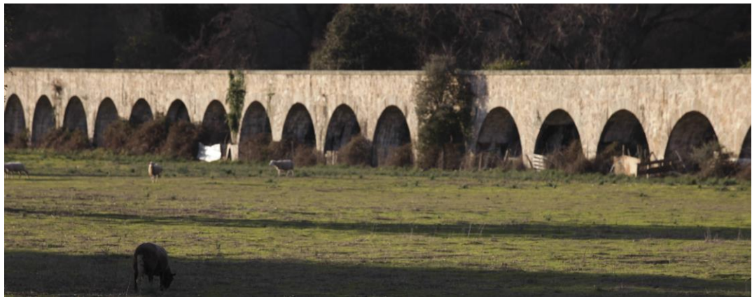
Photo 81. Aqueduc de Mezzana (Sarrola) avec son canal à ciel ouvert qui alimenta la ville d'Ajaccio de 1878 à 1995 grâce à l'eau de la Gravona
