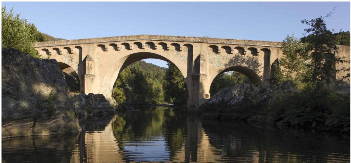
Photo 74. Pont génois de Ponte Leccia (Morosaglia) Loïc COLONNA (2010)
