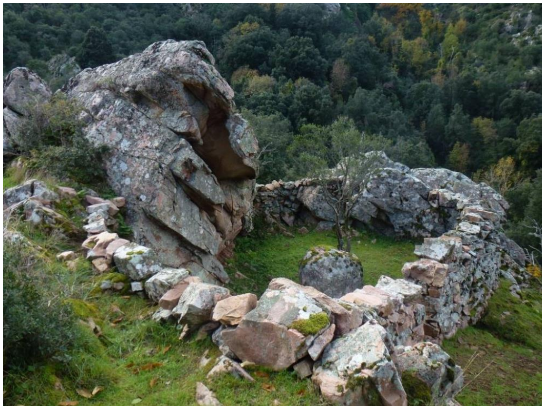
Photo 106. Réfection d'un abri à cochons, Sentier de Cuttoli Corticchiato Office de l'Environnement de la Corse, 2016
