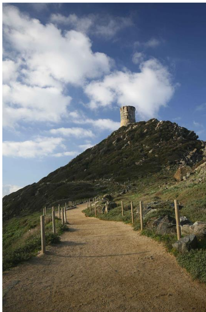
Photo 46. La Parata (Ajaccio) après les travaux OGS de réhabilitation et de mise en valeur du site,
