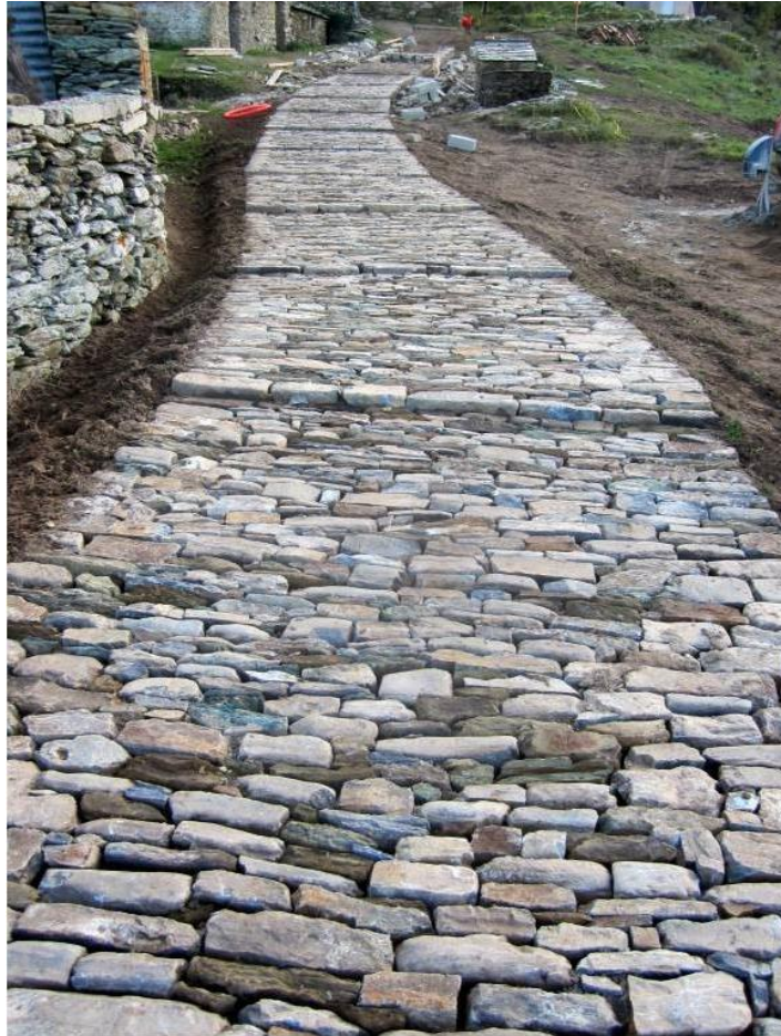
Photo 107. Réfection de l'empierrement du sol selon la méthode traditionnelle de pavage en « Ricciate » (pierre dressée), Sentier de Sorio di Tenda
