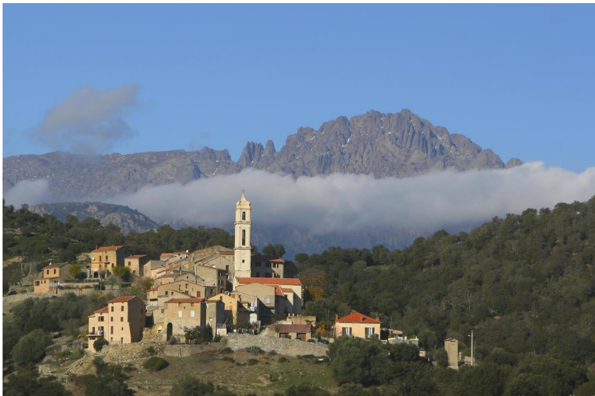
Photo 100. Centre ancien du village de Soveria
