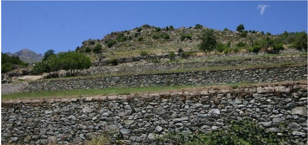
Photo 77. Murs de soutènement de jardin (Calacuccia) Pierre Marie LUCIANI (2015)
