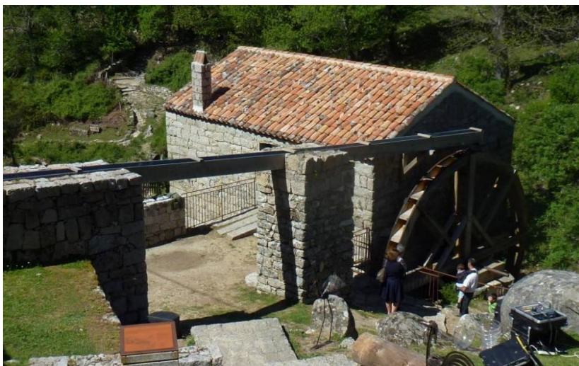
Photo 108. Réfection intérieure et extérieure d'un moulin à eau avec pose de signalétique, Sentier de Serra di Scopamene
