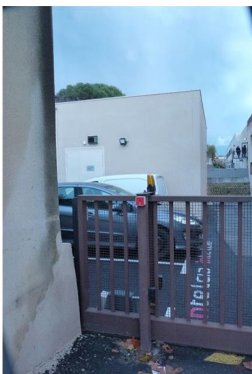
La station dans son environnement direct : située dans une impasse, protégée par un portail électrique, en présence de voitures appartenant à Intelcom.
