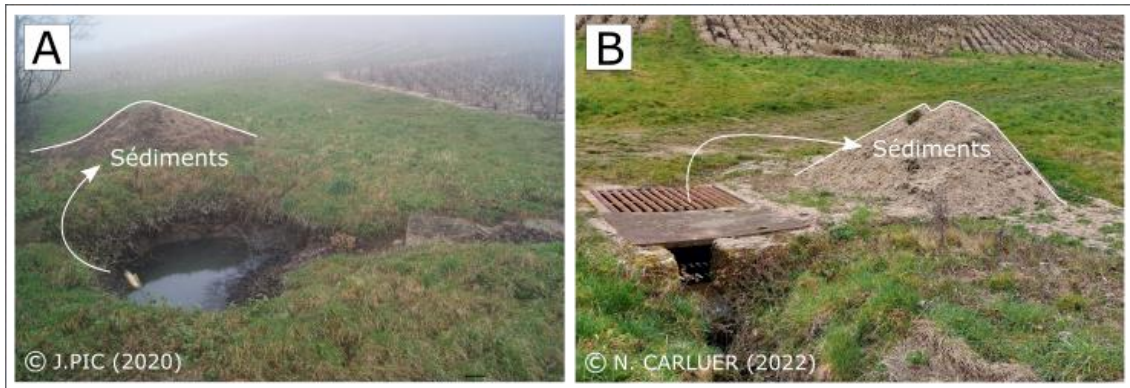
Figure 3-9 : Exemples de pièges à sédiments (Villié-Morgon, Beaujolais). A – Mare ayant été curée. B - Bac décanteur ayant été curé.
