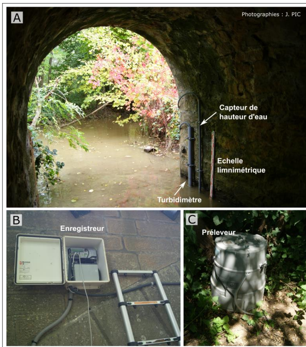
Figure 6-3 : Instrumentation des stations en rivière. A – Dispositif immergé à la station du Ruisseau des Fontaines. B – Enregistreur, station de Pizay. C – Préleveur d'échantillons, station de Pizay.
